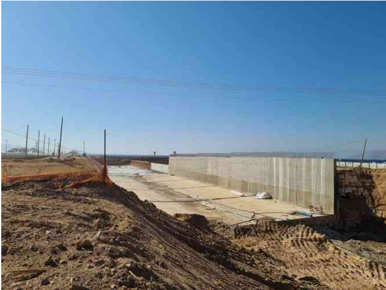
תעלת הקינט המוקמת במסגרת מפעל ניקוז נחל ערבה דרומי; מקור: MKR
