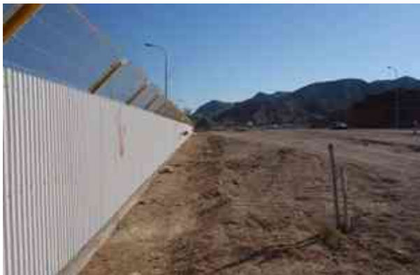
גידור מתקני התשתית ברצועת החוף ; מקור: MKR
